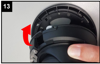
Übrige Kabel gegen Feuchtigkeit abdichten und Verkabelung unter der Kamera verstauen.
